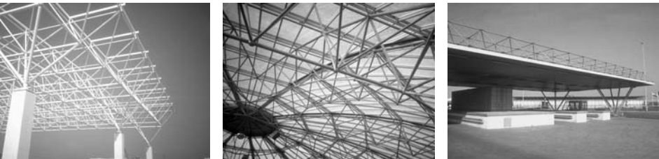
Figuur 2-4 Voorbeelden van space frame structures door Octatube (v.l.n.r. dak luchthaven Dubai, tropisch zwembad Bremen en douanecomplex in Hazeldonk)
