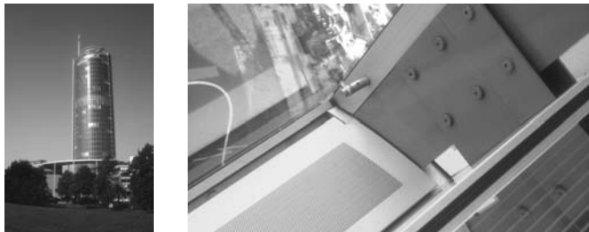
Figuur 6-7 Ingenhoven, Overdiek & Partner ontwierpen het nieuwe hoofdkantoor van RWE in Essen met een tweedehuidfaçade
