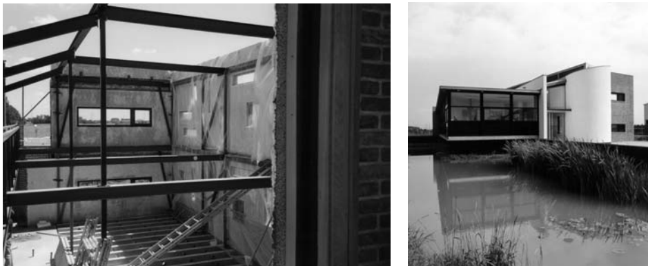
Figuur 38-39 Tijdens de bouw en het uiteindelijke resultaat
