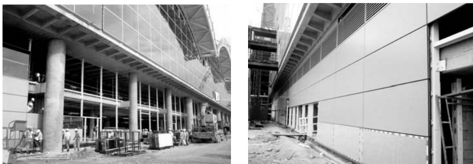
Figuur 14-15 De montage van de sandwichpanelen
