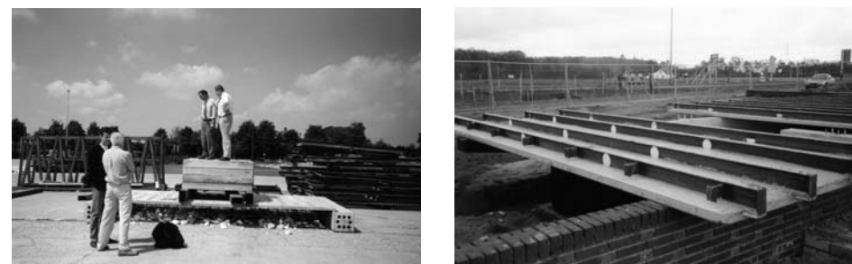
Figuur 36-37 Het testen van de vloer en de vloer tijdens de bouw
